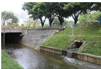
河道中管道排放口位置
