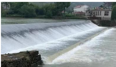
河道中斜坝急流区段
