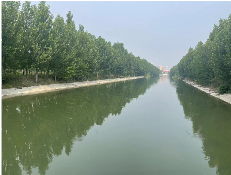
选择流速平稳且直渠道长度满足“前十后五”安装位置
